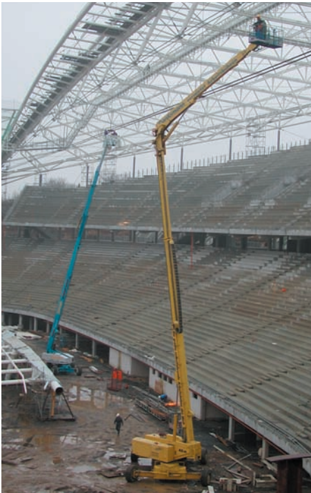
Bild 6-2: Hubarbeitsbühne im Baustelleneinsatz
